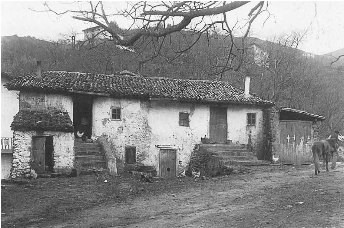
Figura 30 Caserío de "El aldeano". A la derecha cobertizo para el carro. Calle Urkullu
