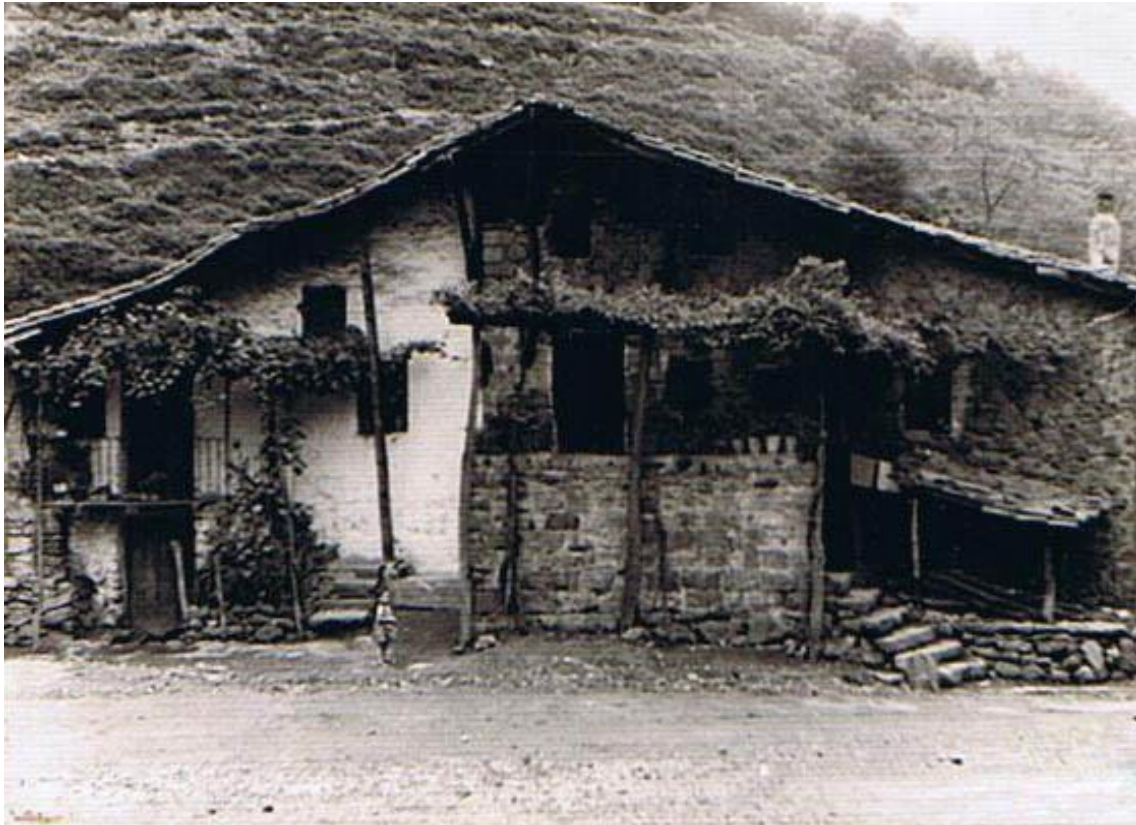
Figura 29 Caserío de Macario Aldasoro. A la derecha cubierta para el carro. Calle Eskauritza
